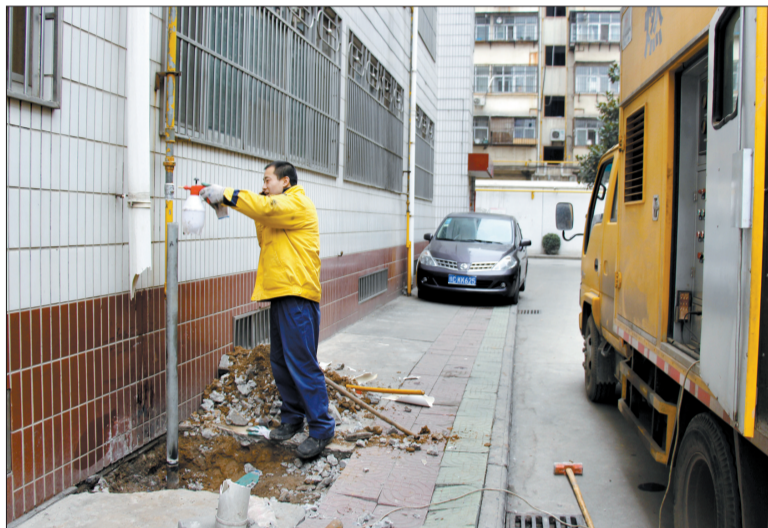
新管道装上后,抢修人员进行漏气检测
