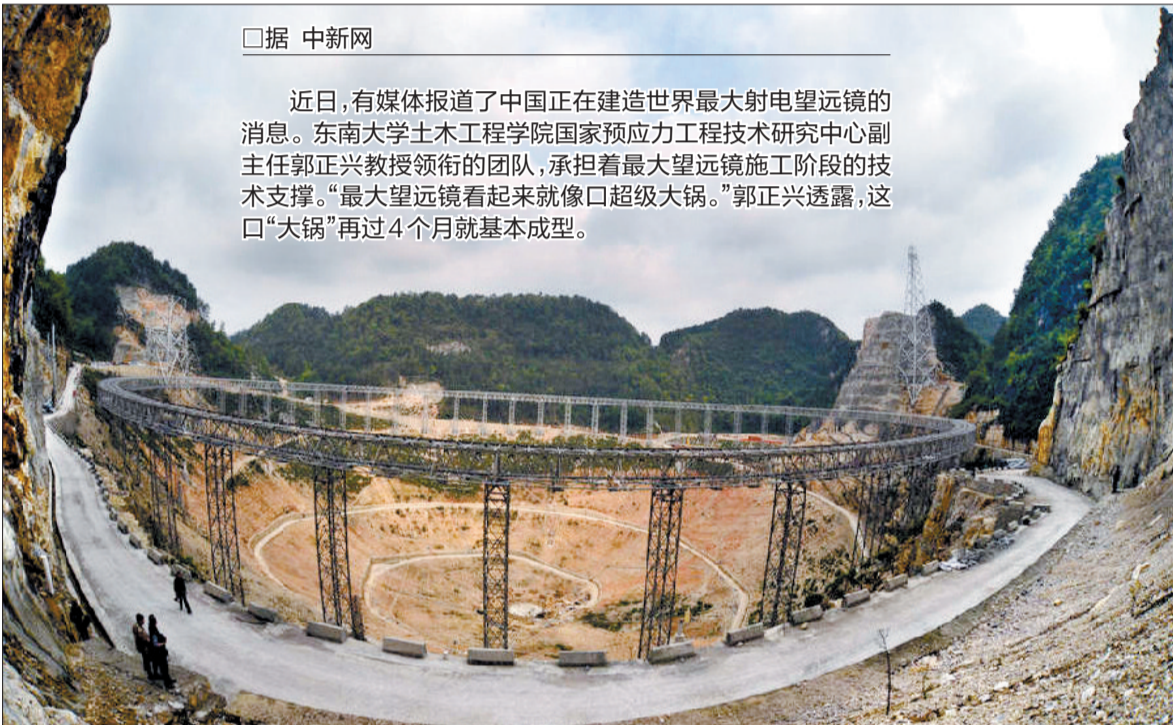
FAST项目建设现场(本版图片均为资料图片)
