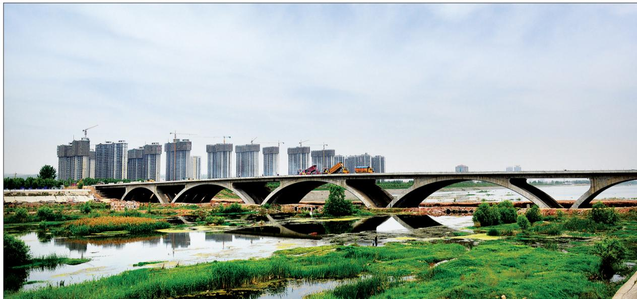
4日,在伊川县滨河新区志远路跨伊河大桥工地上,承担施工任务的洛阳市政建设集团的工人们正在有序地加紧摊铺桥面沥青。该大桥全长1350米,宽29米,主桥为五孔拱桥结构,按景观桥设计,犹如彩虹横跨伊河,本月底前建成通车后,不仅方便沿河两岸群众出行,还将成为该地域一道风景。 记者 高山岳 李卫超 摄影报道 通讯员 贾光明 摄
