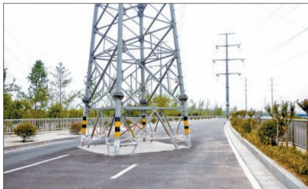
有些庞大 位于道路中间的高压线塔，身躯
