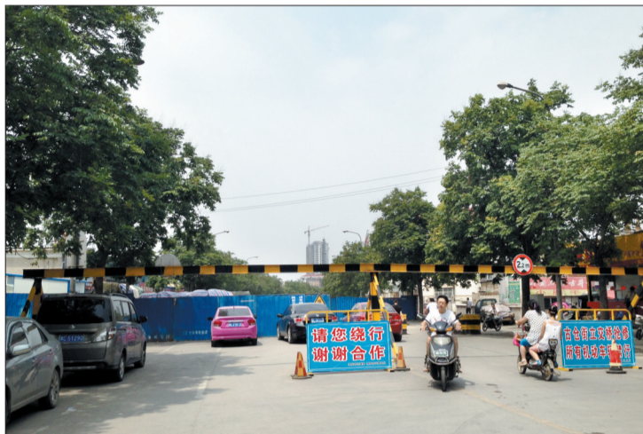
古仓街立交桥封闭维修现场
