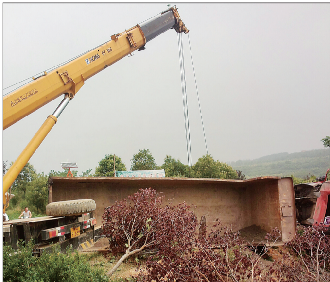
吊车正在将车吊出沟
