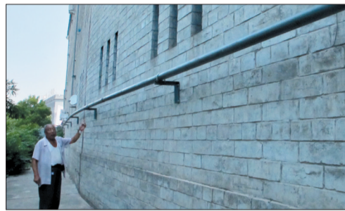
看着新装的天然气管道,周汉章高兴不已
