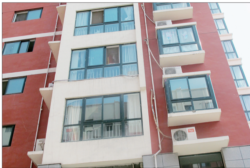
安泰华庭小区楼房外景
