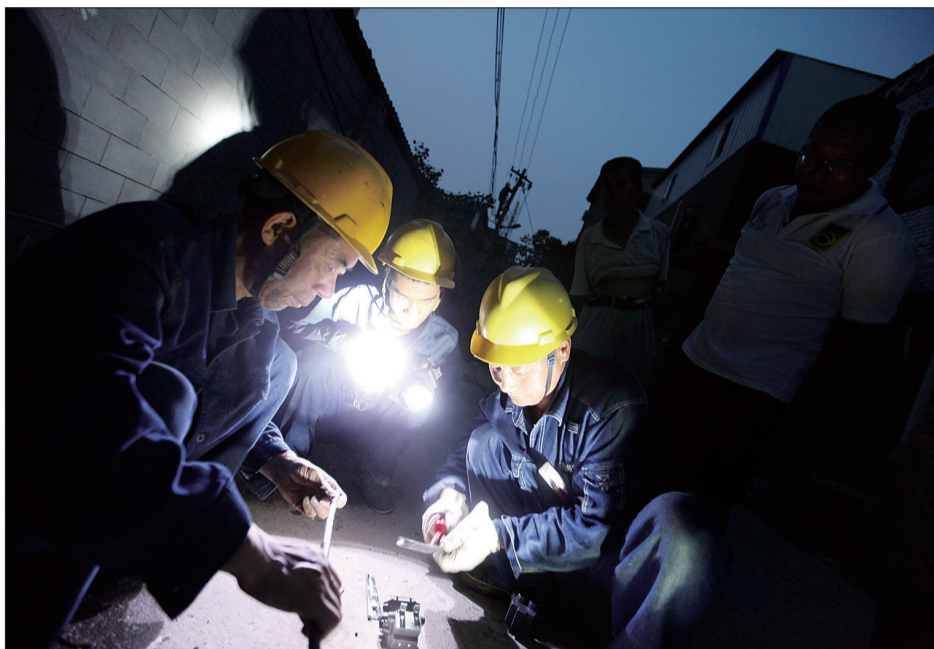
电力工人正在更换变电站内受损的设备
