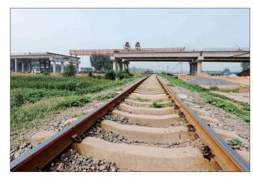
昨日,在洛栾高速公路洛阳连接线大桥工程工地上,市政建 设集团的工人们正加紧进行桥梁吊装和桥面钢筋网铺装施工。
