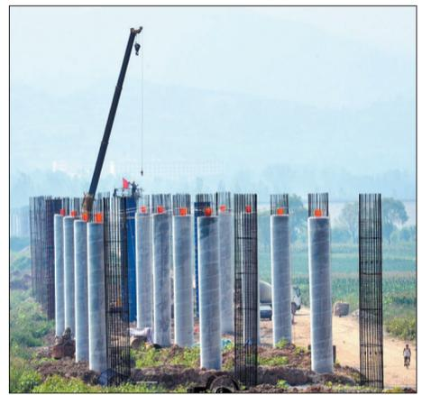
27日,嵩县跨越陆浑湖大桥建设工地机声隆隆,工人们正加紧筑造桥墩。
