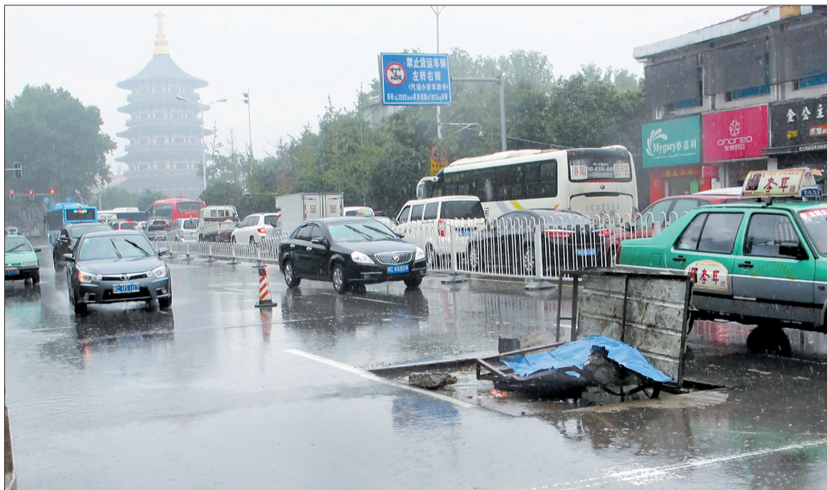
定鼎南路有的施工围挡已被撞坏
