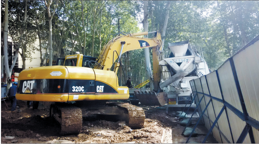
基座里灌注混凝土 青岛路西苑路路口,施工车辆正在往新的高压线架
