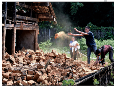
地震灾区民房损毁严重
