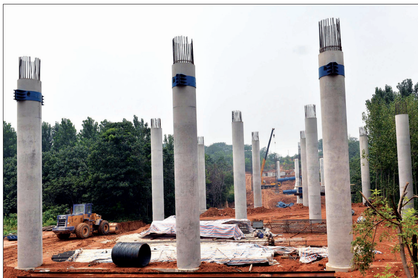
正在建设的林沟大桥,选址几乎完全避开了村民居住区
