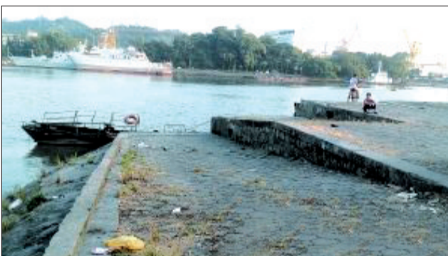
事发码头斜坡 (网络图片)
