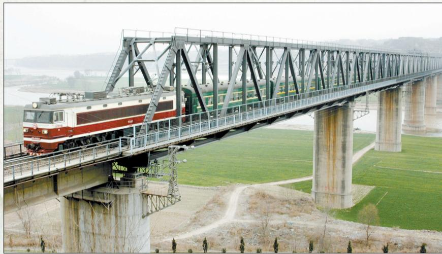
洛阳黄河铁路桥,是焦柳铁路上行线跨越黄河的一座钢桁梁结构特大桥。它北起济源市坡头镇连地村,南至孟津县白鹤镇柿林村,全长937米,于1970年建成通车。
