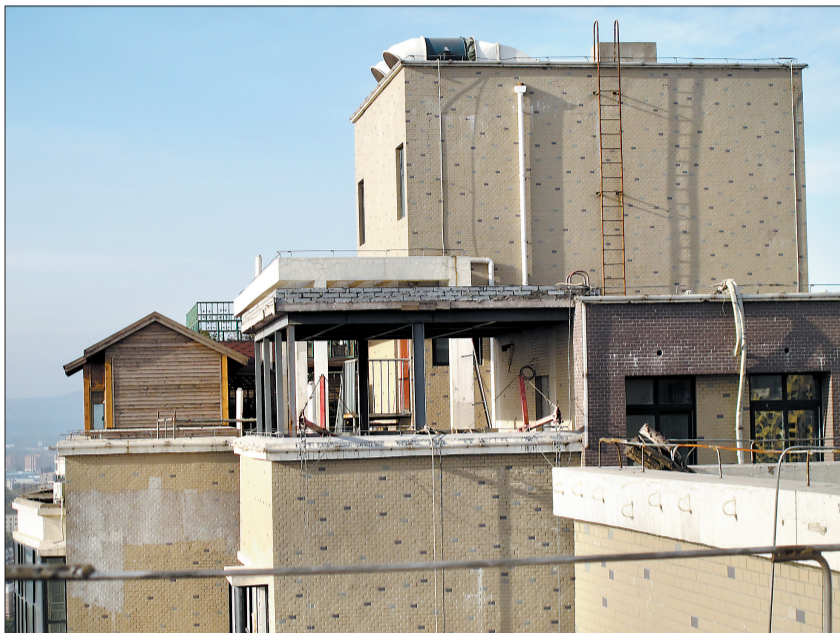
水木菁华小区楼顶的木质房
