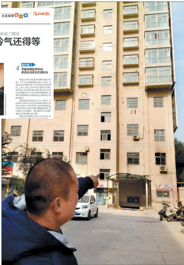
廖先生说,该楼只有个别物业工作人员家装了空调
