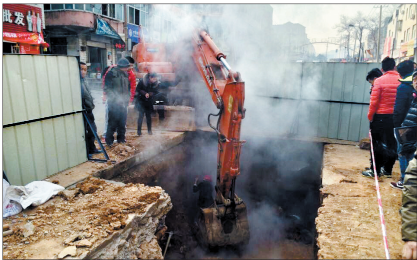
在故障现场,沟槽内依然有热水流出
