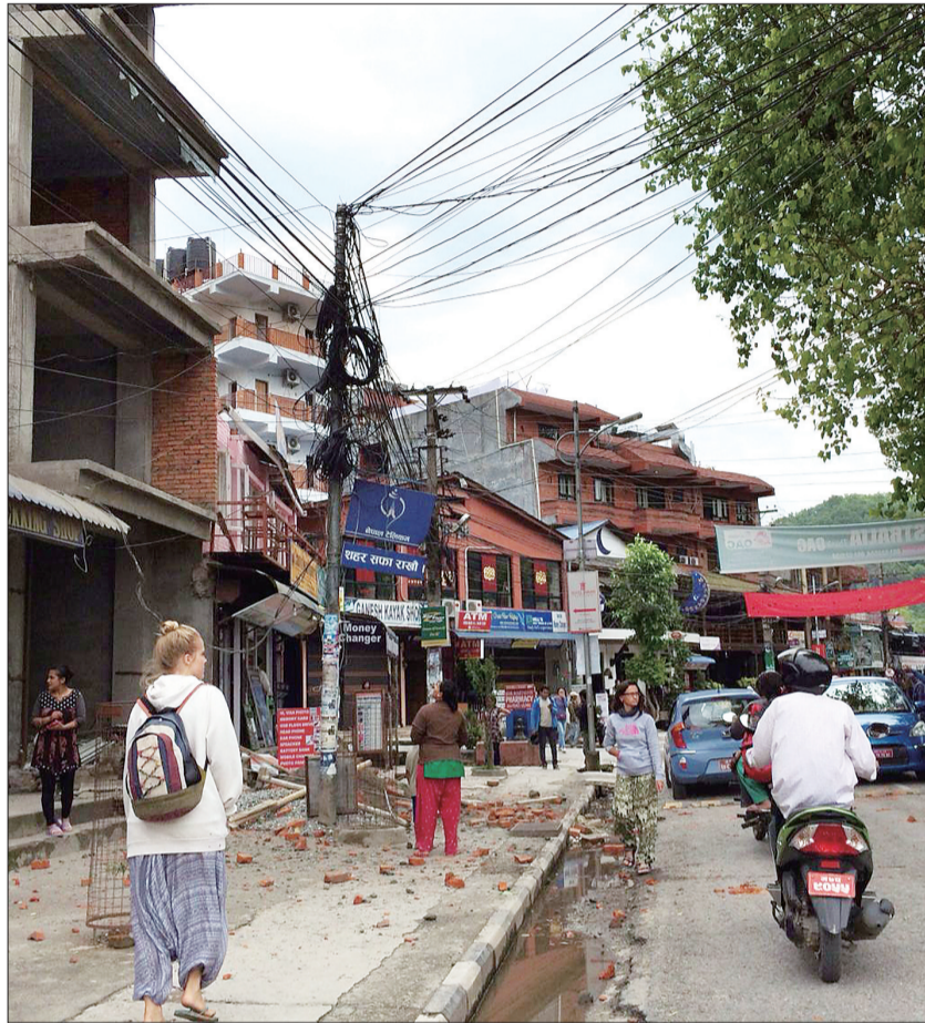
博卡拉的房屋受损情况并不严重（刘霖供图）
