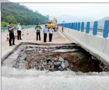
下陷路面已被挖开,相关人员正在勘查地质条件
