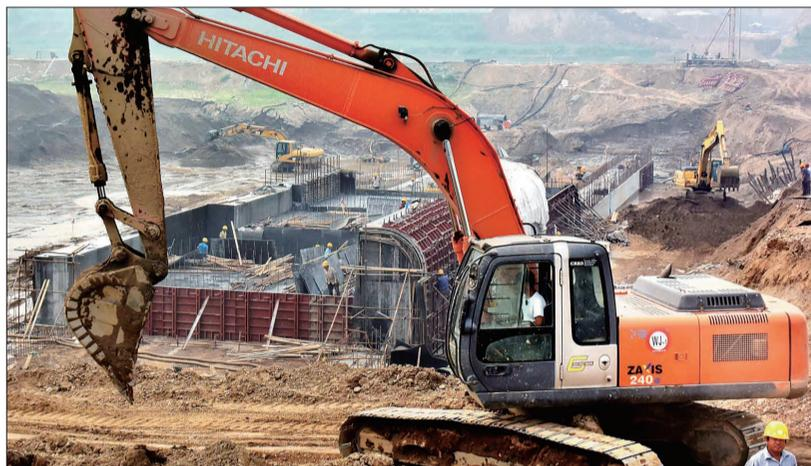
9日,位于白马寺镇枣园村东大桥下游2公里处的洛河东湖拦河坝建设工地上机声隆隆,一派繁忙景象,施工人员正在加紧浇筑坝体混凝土。
