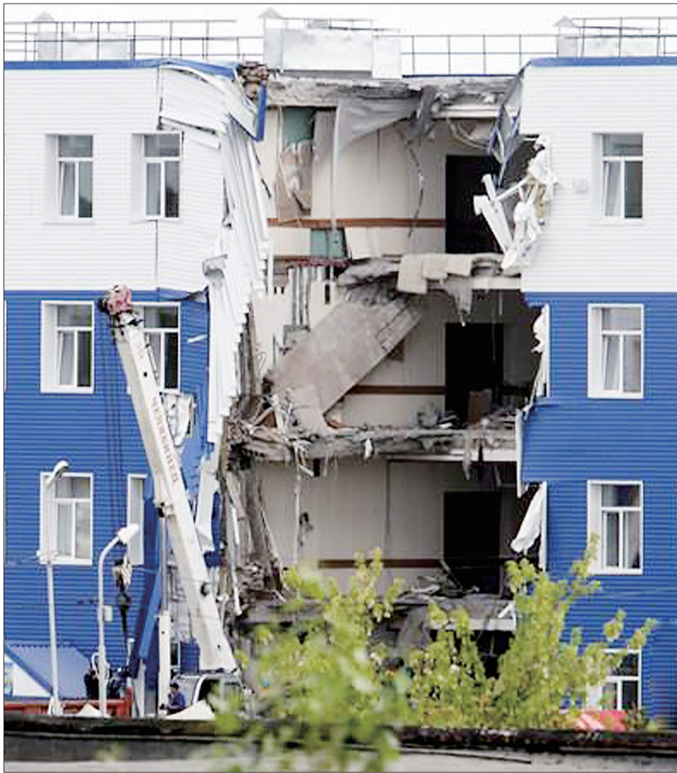
发生坍塌的营房
