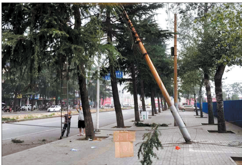
电力维护人员正在抢修电缆
