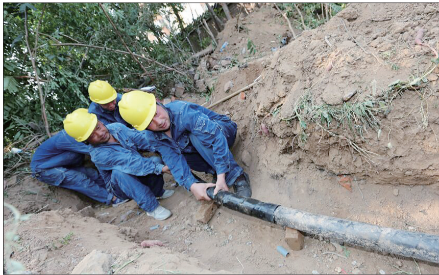
电力工人抢修线路
