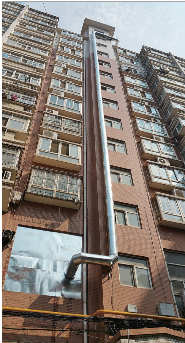
从2楼延伸到12楼的烟囱
