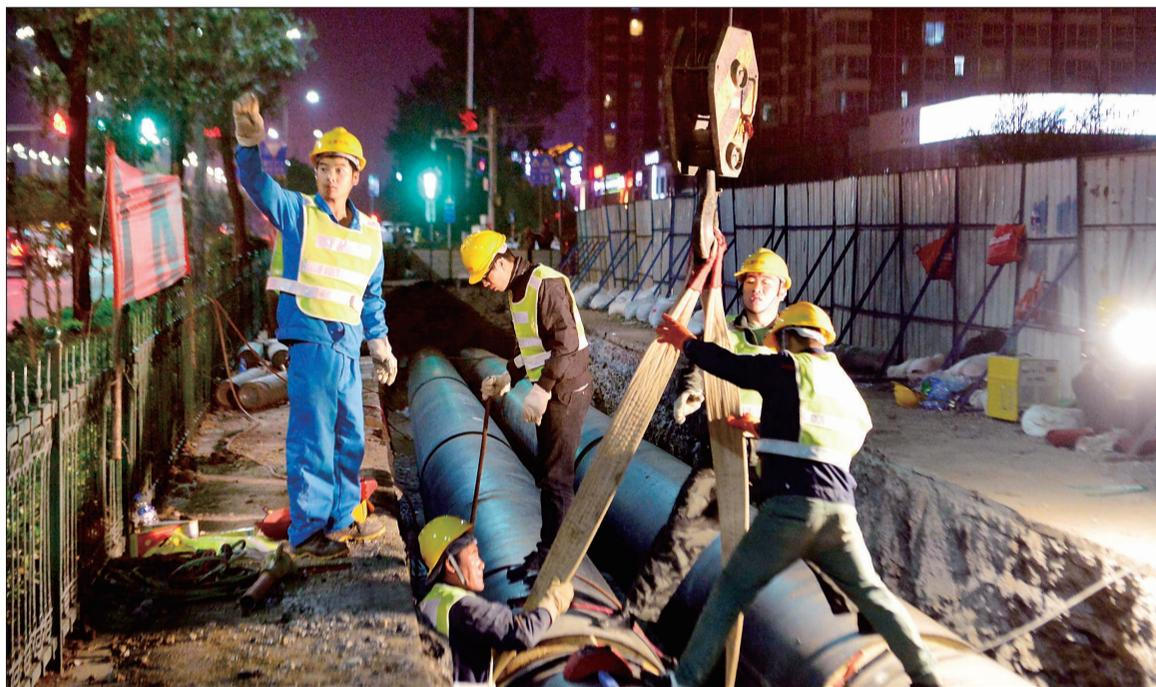
2日,在龙门大道与古城路交叉口附近的热力管网施工工地上,施工人员正在紧张施工
