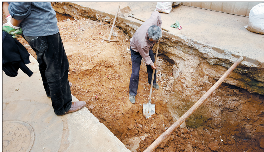
工人在黔川路工地内排查管线情况
