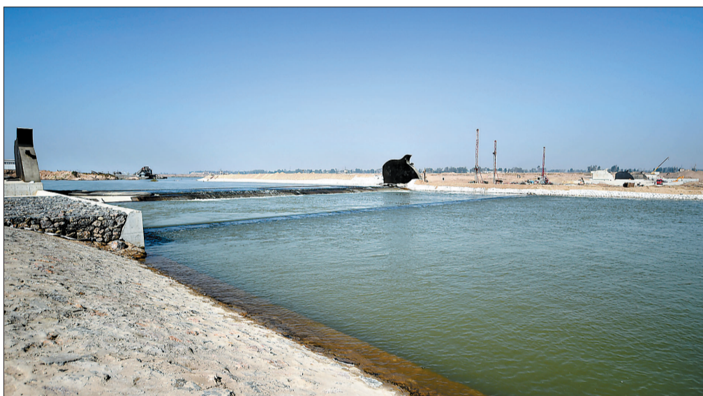
为保证五跨和六跨无水作业,伊河被引流,从已建成的七跨上流过
