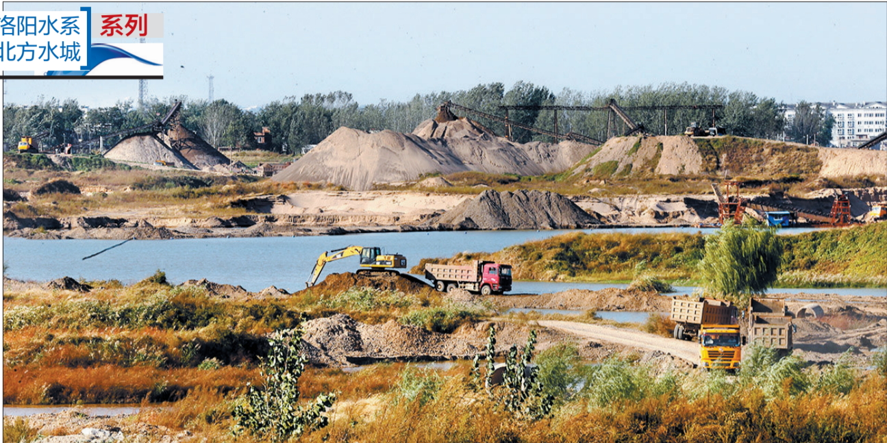
伊河东湖施工现场
