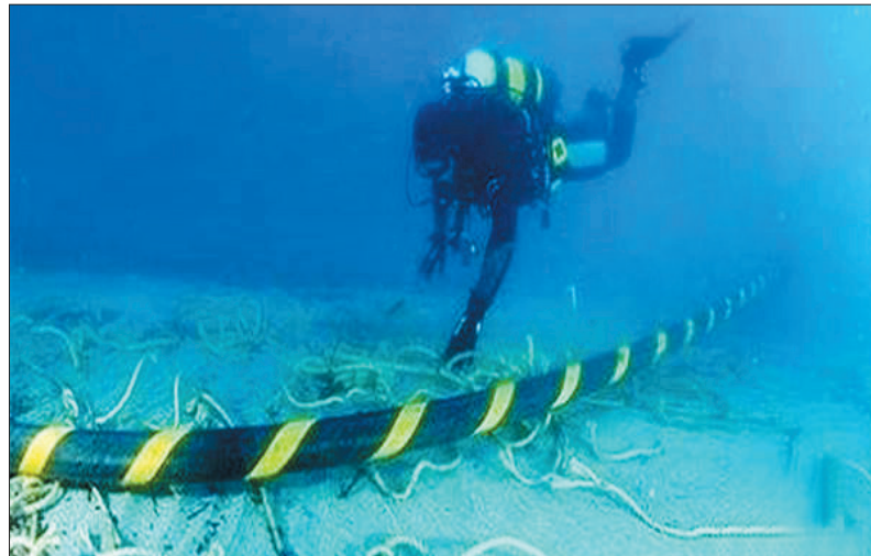
潜水员查看海底电缆 (网络图片)
