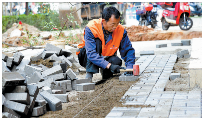
施工人员在丽春西路施工
