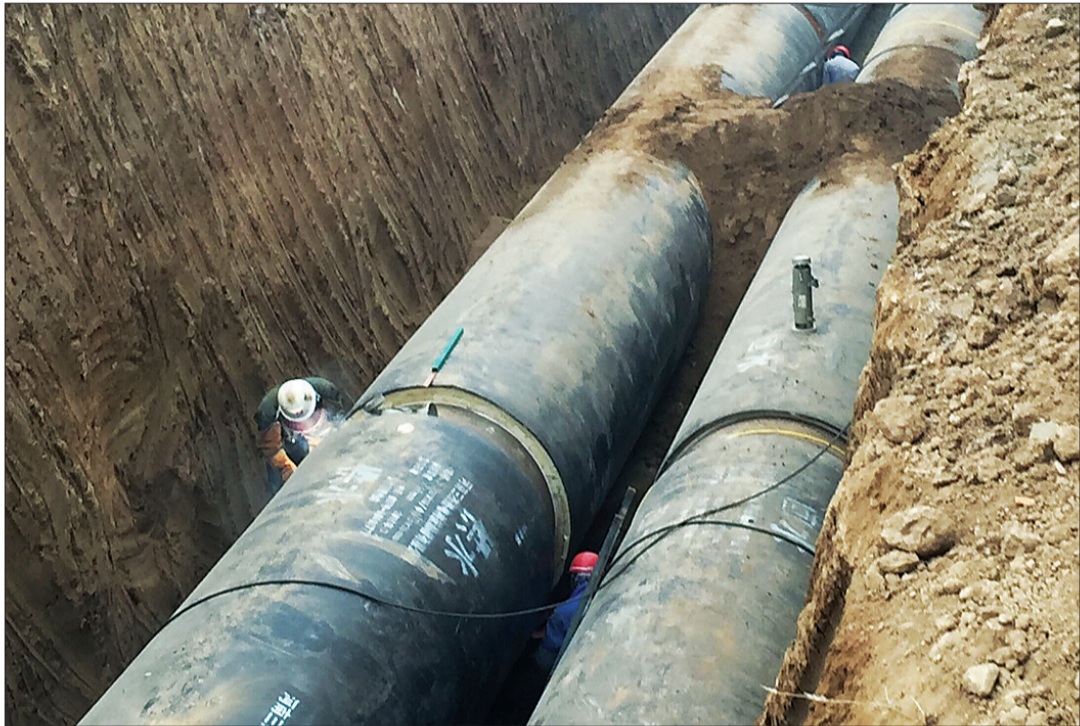
工人正在抓紧施工
