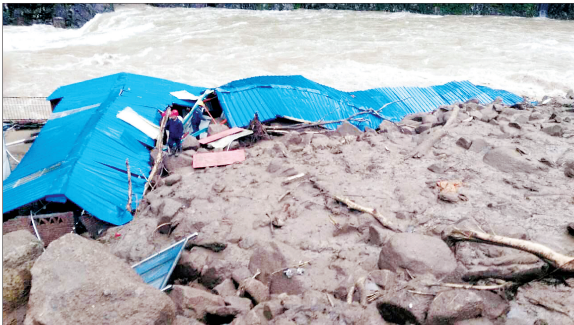
山体滑坡事故现场
