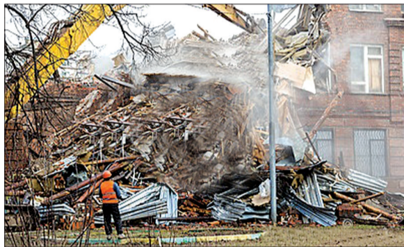
2015年3月，挖掘机在莫斯科拆除苏联时期的一栋教学楼
