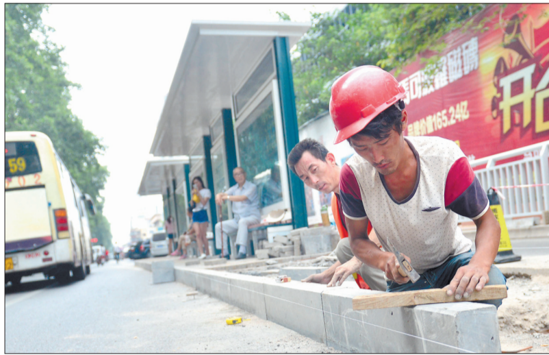
施工人员正在修复被毁的公交站台
