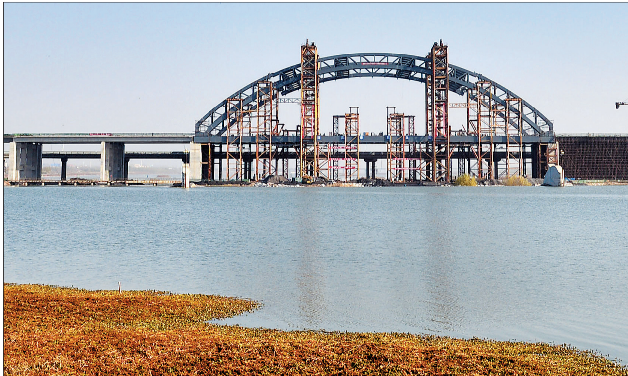
东环路跨洛河桥主跨钢桥合龙
