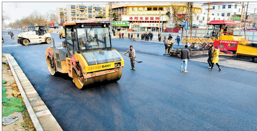
施工人員正在摊铺面层沥青
