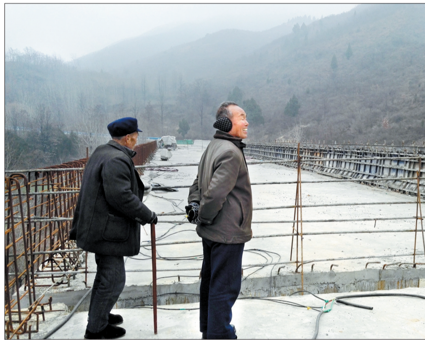
位于东南村桥附近村民靳师傅和哥哥(拄拐杖者)来施工现场询问停工原因
