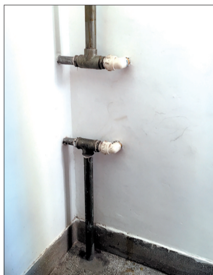
该暖气片改装前的位置
