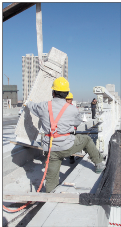
工人安装防护栏
