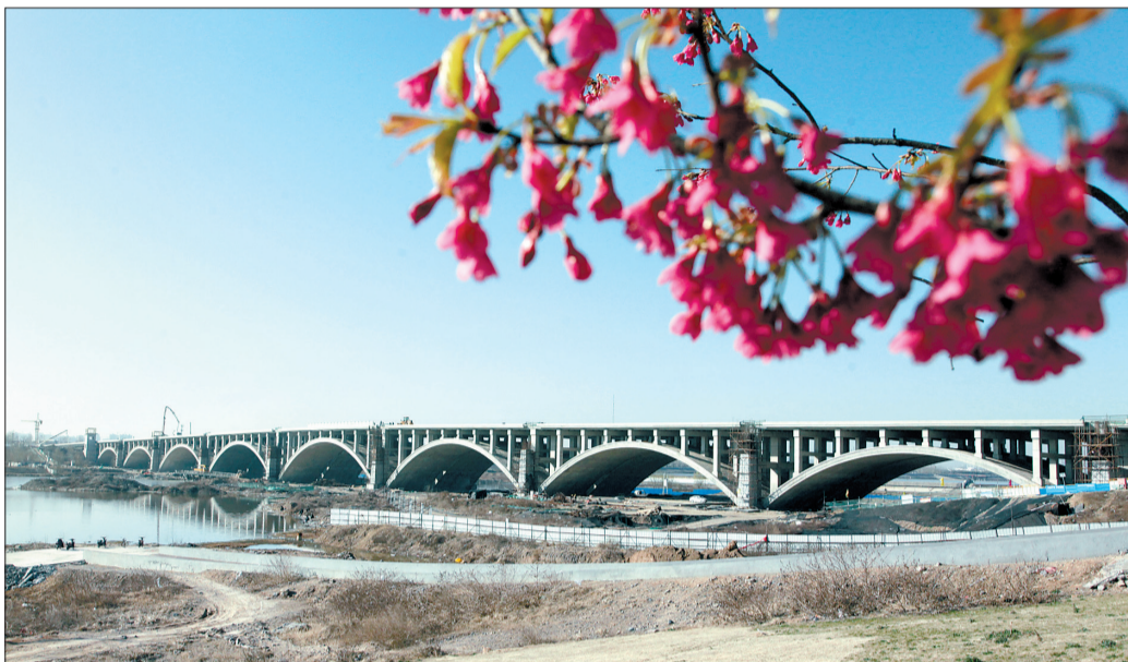
新街跨洛河大桥主桥月底前将全面完工
