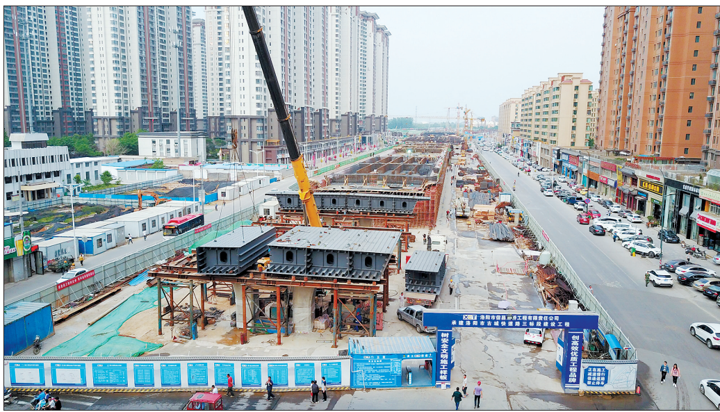
古城快速路一期工程施工忙
