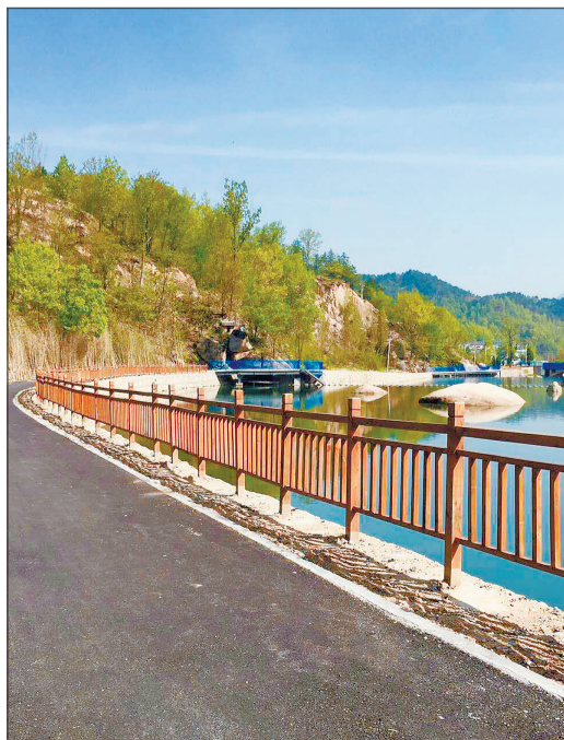
城筑·伊河源社区实景图
