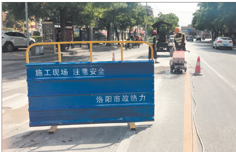
热力工人正在切割路面，为敷设管网作准备
