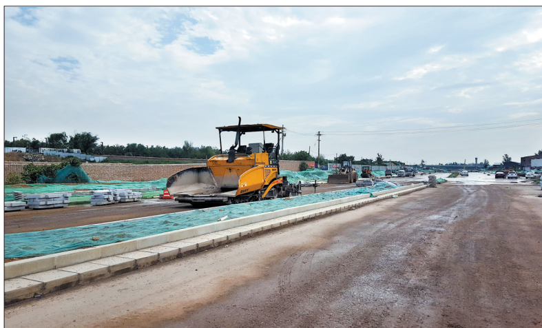
建设中的滨河南路东延工程
