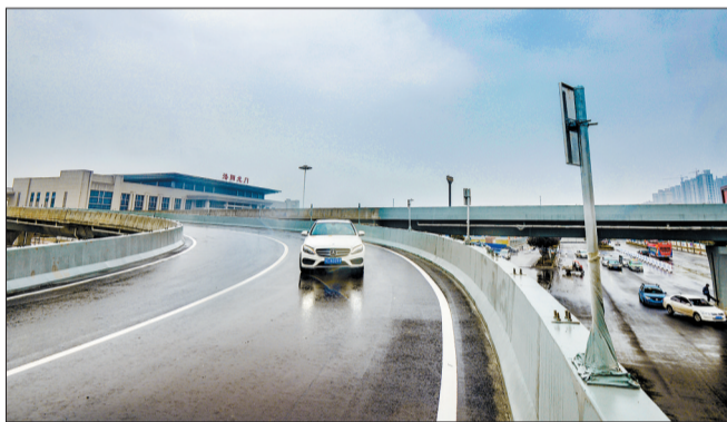
洛阳龙门站综合交通枢纽北广场一期东侧匝道
