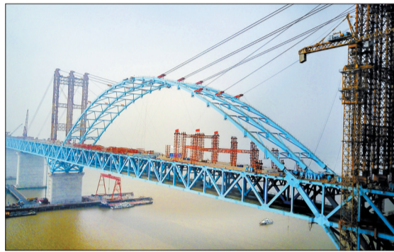
沪通长江大桥天生港专用航道桥 (新华社发)
