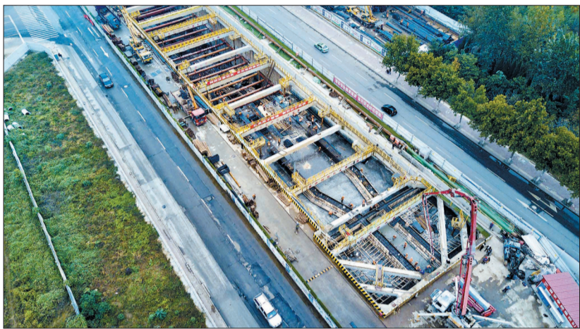
从空中可以看出,一部分顶板已经浇筑完成
