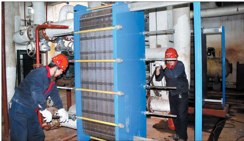
热力工人对小区换热站进行检修、维护
