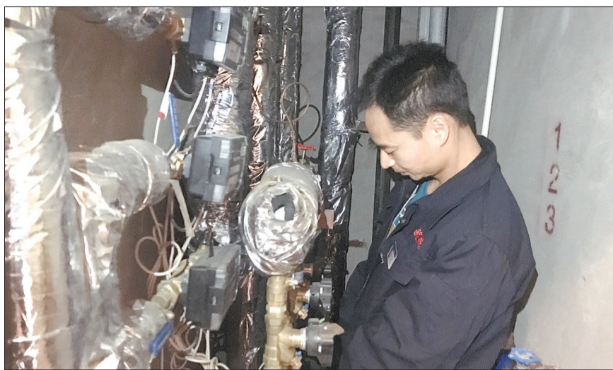
王俊峰为用户开阀门、打压试水
